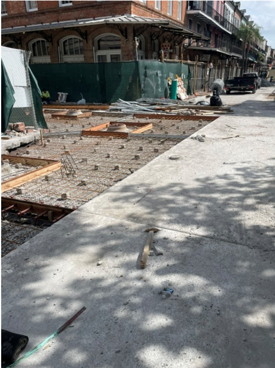
Decatur & Ursulines getting ready for final concrete pour
